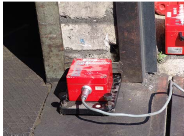
Bild 3.1b Messpunkt MP 2 (Gebäudeschwelle)
