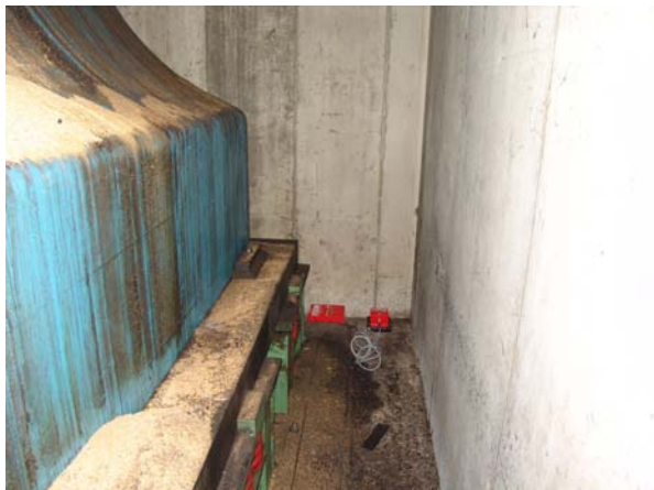
Bild 3.1a Messpunkt MP 1 (Hammerfundament)
